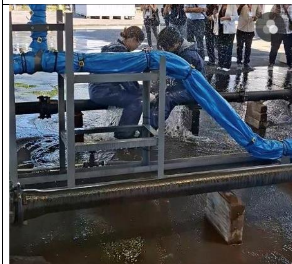
圖 2.41 演練高效率的帶壓管段對接技術
