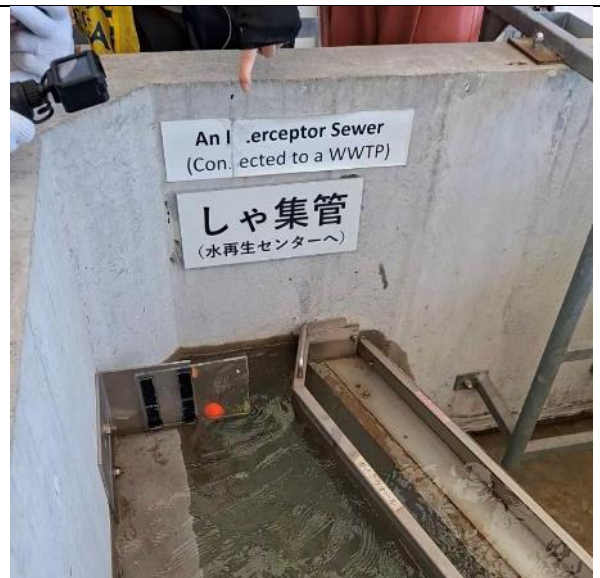
圖 2.14 產生漩渦吸入漂浮物
