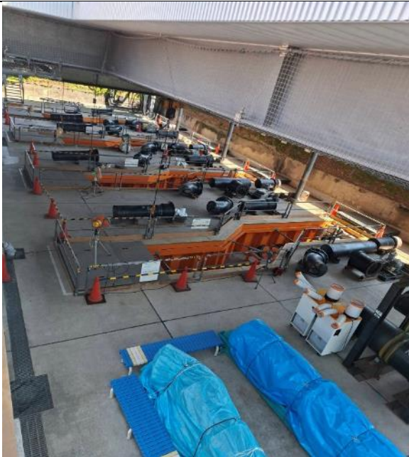
圖 2.33 管線施工演練區(含訓員休息設施)
