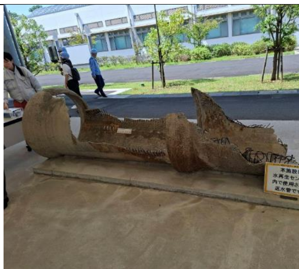
圖 2.8 管材腐蝕損壞展示
