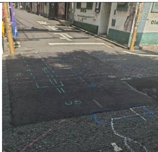
圖 2.68 日本道路下水道與地下管線試挖噴漆標 記現場
