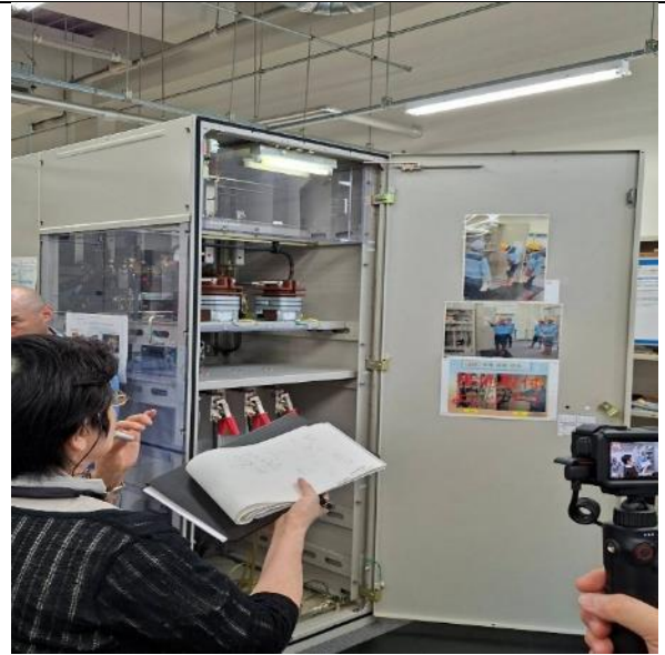
圖 2.26 高壓配電櫃作業標準程序演練
