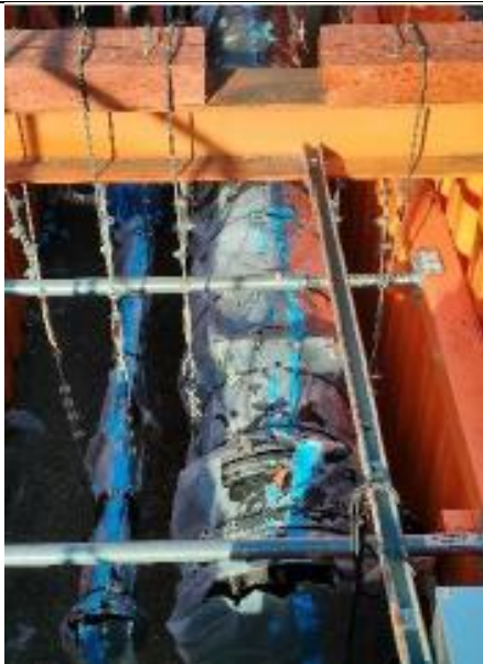
圖 2.37 吊管及埋設展示
