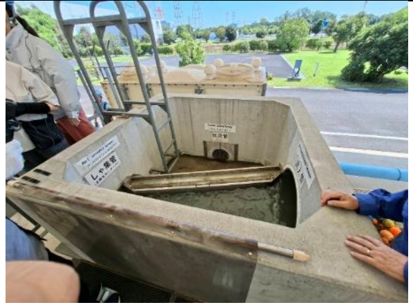
図 2.10 合流式下水道展示
