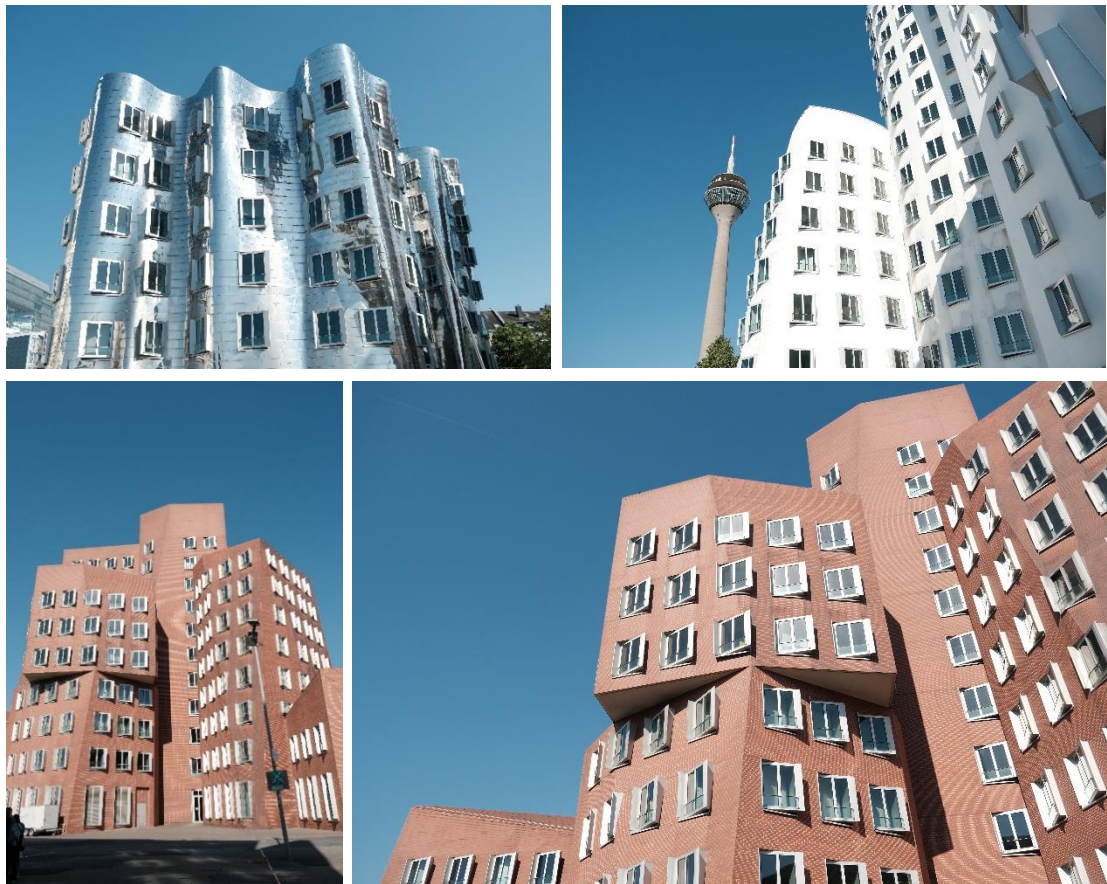
圖2.12 Frank Gehry 設計的3棟新關稅大樓
