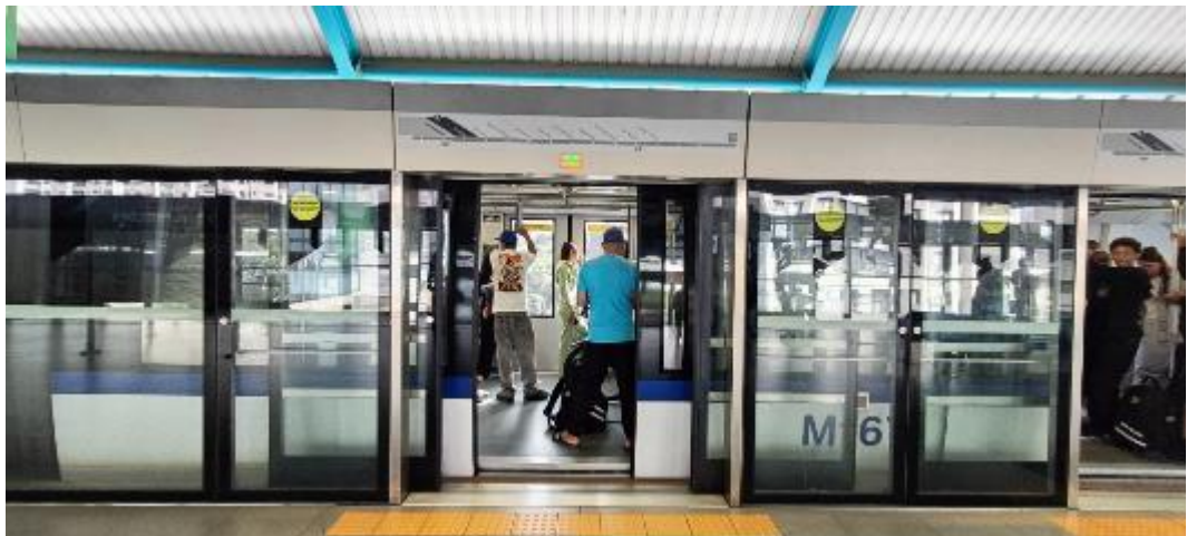
圖 88 聖保羅捷運 15 號線月台門配置
