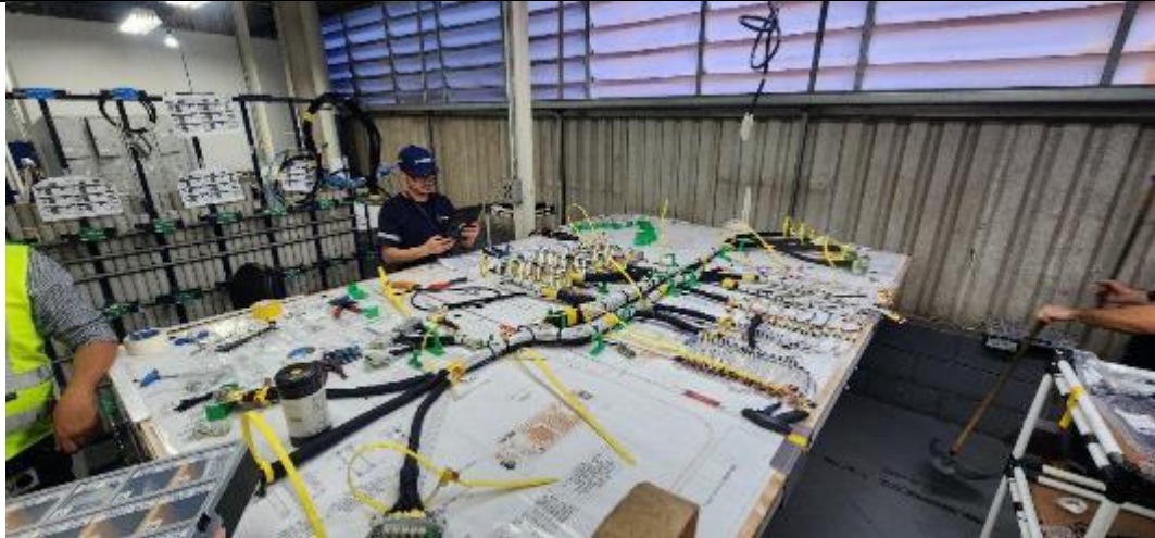
圖 16 電纜線組預組裝
