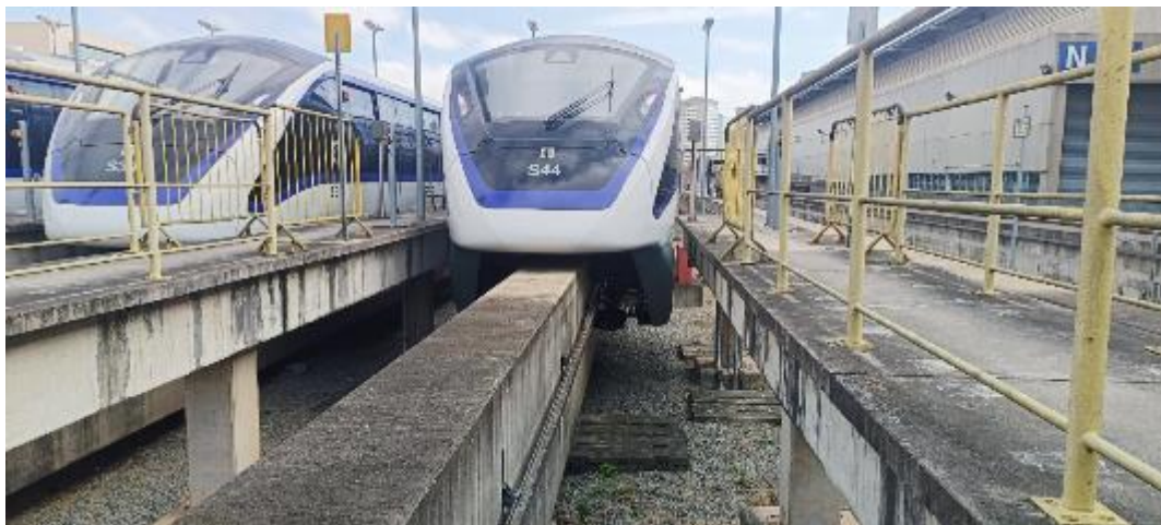
圖 98 聖保羅捷運 15 號線機廠停車線
