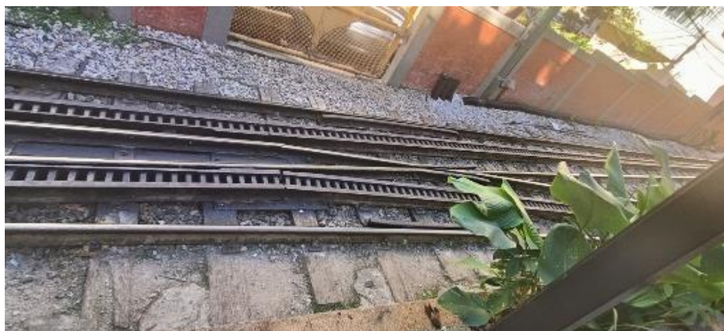
圖 151 Riggenbach 齒軌系統
