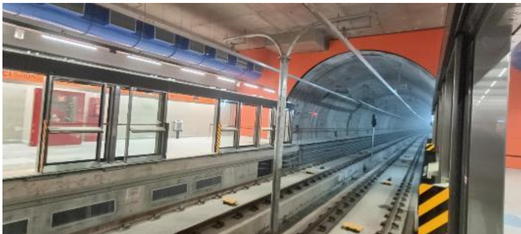
圖 109 聖保羅 6 號線地下車站採用架空式導電軌
