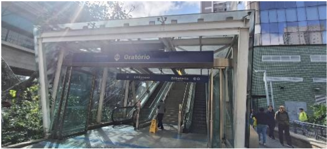
圖 85 聖保羅捷運 15 號線車站出入口
