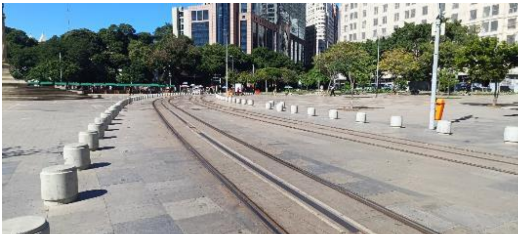
圖 78 APS 系統路面第三軌
