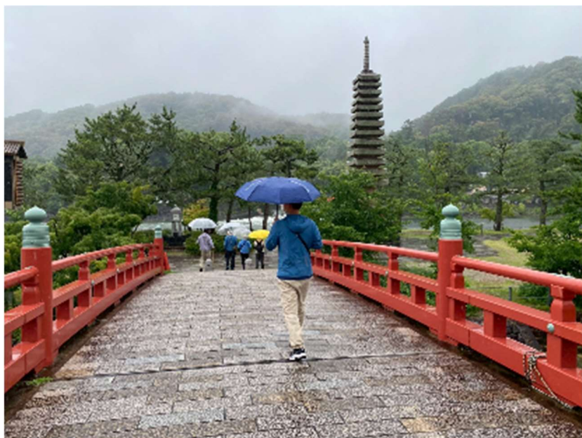
圖 3.20 連接市區與塔之島的喜撰橋以及島上石塔地標
