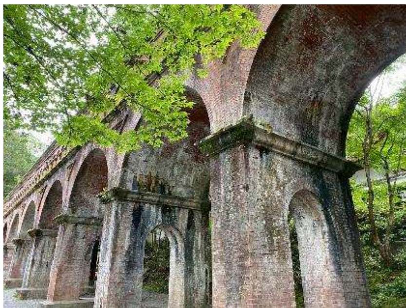
圖 3.14 南禪寺水路閣仿羅馬式紅磚拱橋輸水設施
