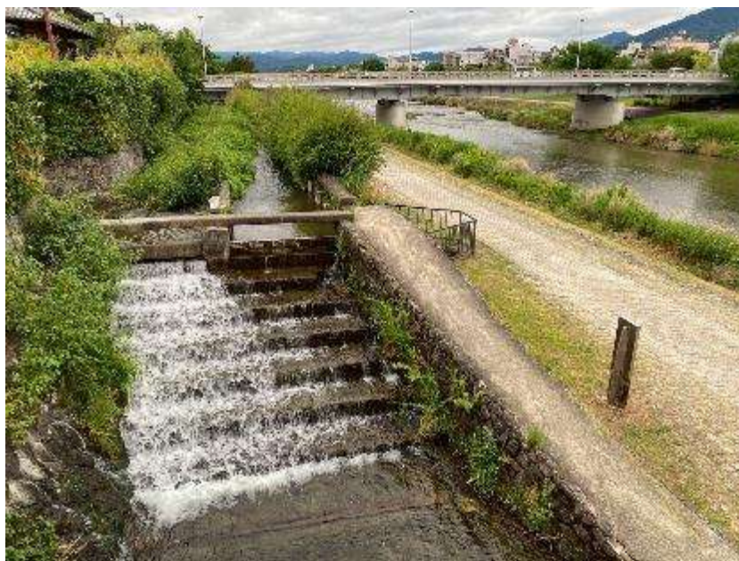
圖 3.15 鴨川內楔川分流降低環境溫度供納涼床使用
