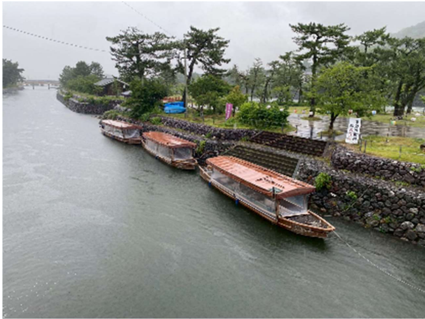
圖 3.19 宇治川河道護岸設施及因雨停駛之遊船
