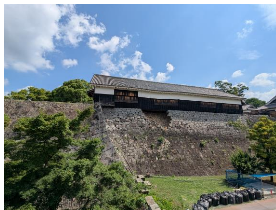
圖 1.3.48 部分古蹟仍處於修復階段
