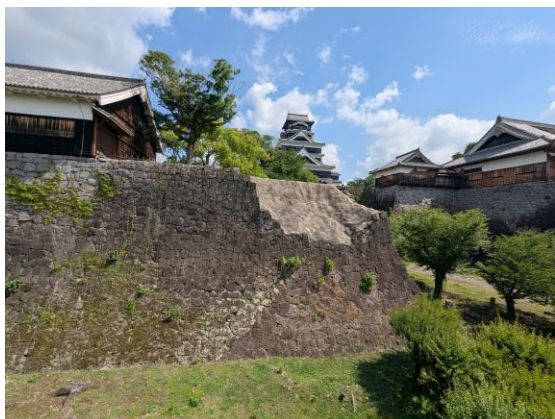
圖 2.4.25 石牆修復作業
