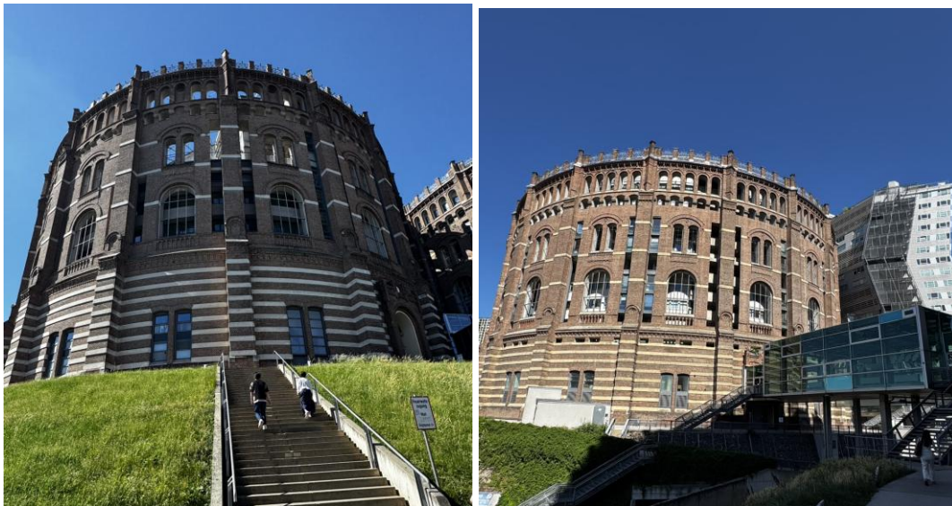
圖 2.3 Gasometers 瓦斯罐群，左圖為 D 棟、右圖為 B 棟
