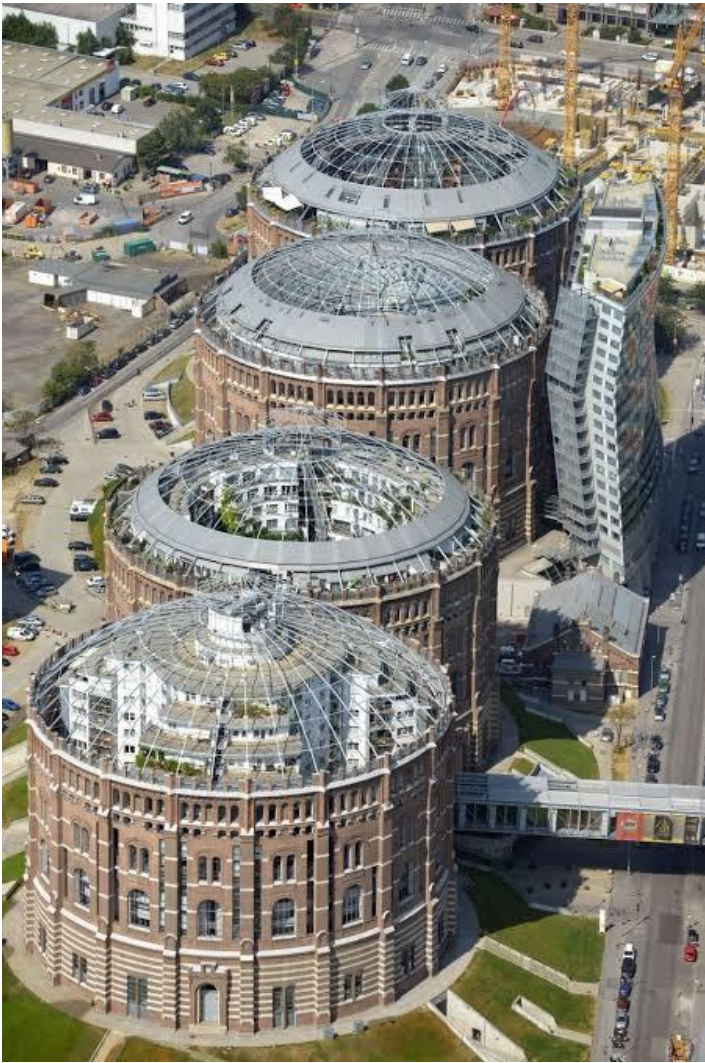
圖 3.2 Gasometer 空拍景（資料來源：網路）
