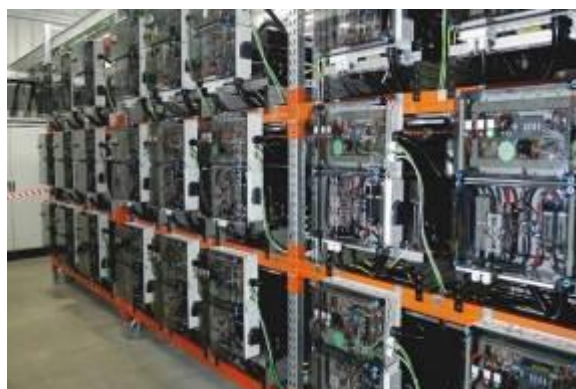
圖 2.4.8 電動車退役電池二次利用儲能系統
