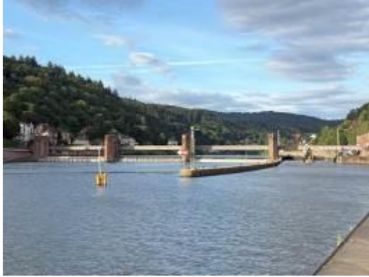
圖 2.4.25 海德堡老橋附近（Karlstor 堰壩） 之水力發電系統(3,000 kW)
