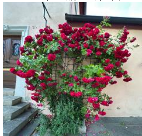
圖 2.4.24 羅騰堡的牆面綠化框架，讓植物保持在合宜高度，美觀也不破壞牆面結構
