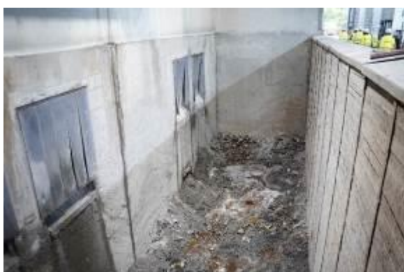
圖 2.4.13 赫德海姆焚化廠底渣處理
