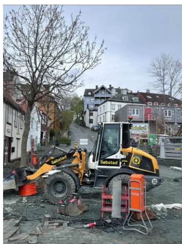
圖 22 純電式工程設備機具與怪手
