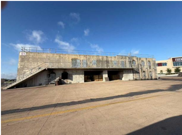
圖 8 複合建築物搜索與滅火訓練設施
