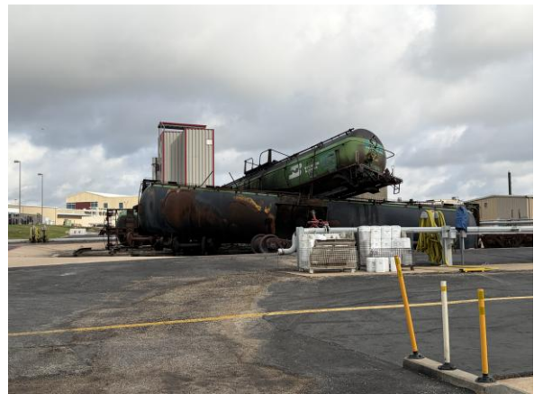
圖 9 危害物質車輛翻覆滅火訓練設施
