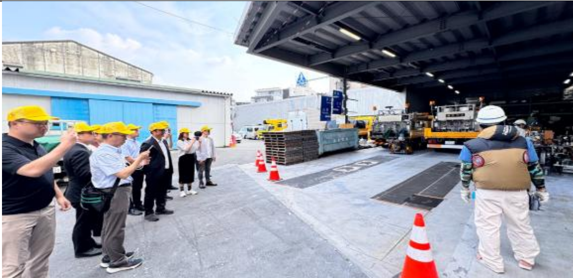
圖2.4.11 標線施工機具與施工車輛
