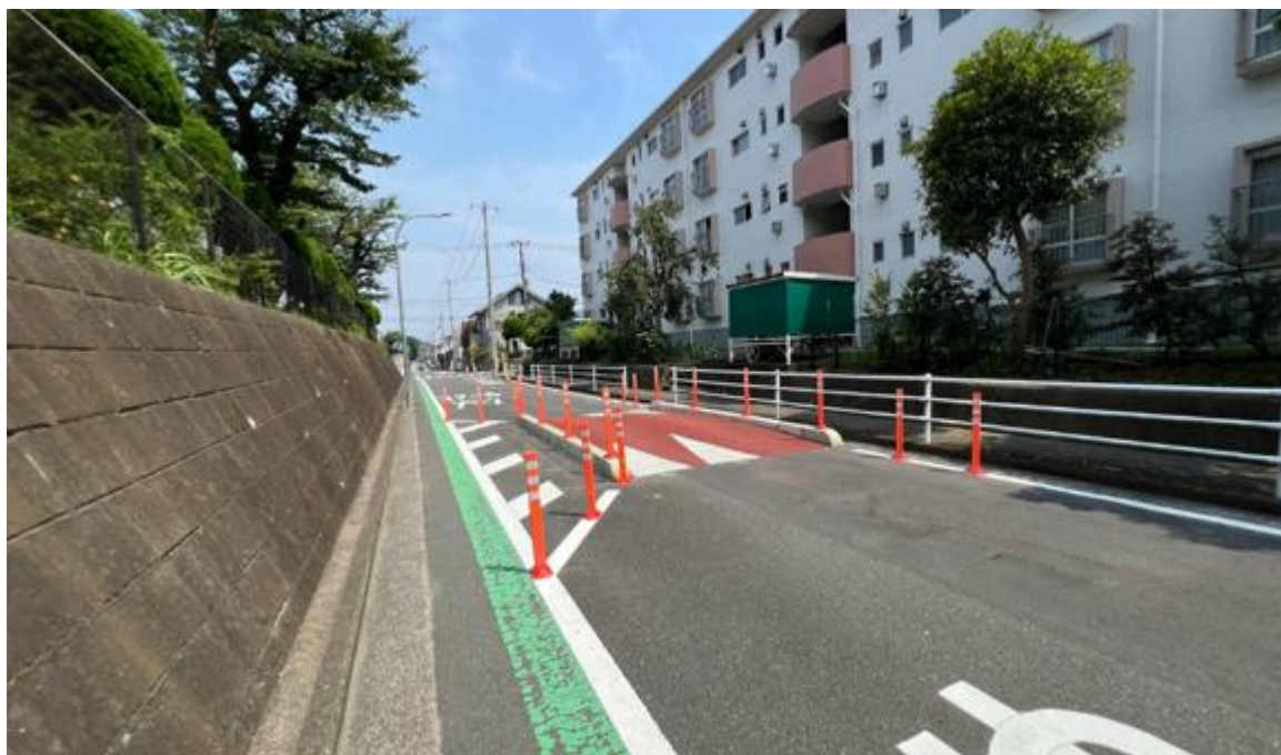
圖2.3.6 路段中實體減速丘及車道縮減(槽化線、交通錐)
