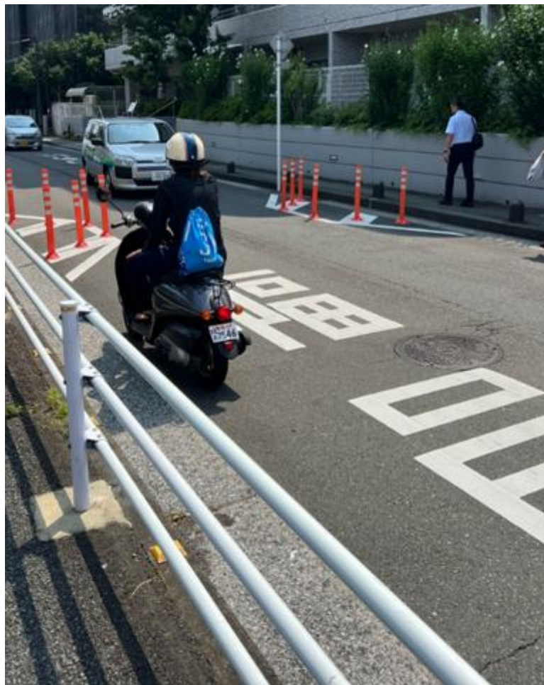
圖2.3.10 以槽化線及交通桿縮小車道寬度
