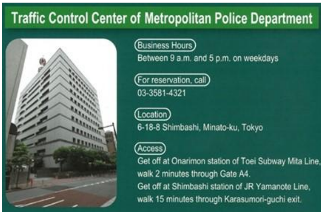
圖2.1.1 東京警視廳交通管制中心外觀
