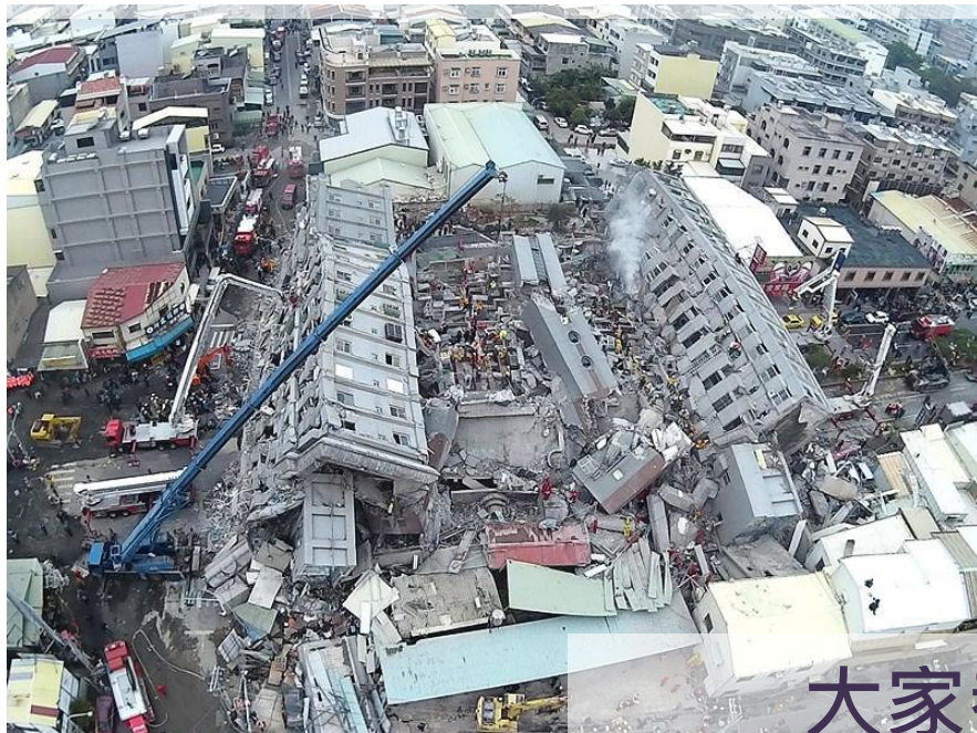
105.2.6南台灣6.4級地震，台南市維冠大樓倒塌
