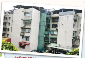
中和圓通路增設電梯完工現況
