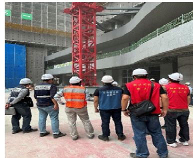
委任專業機構檢查設備
