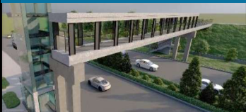
發包作業中 預計113年完工
