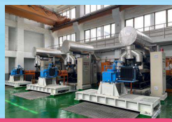
光復站更新3組抽水機組
