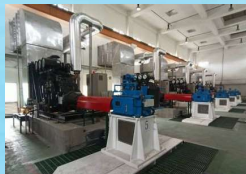
新海站更新5組抽水機組
