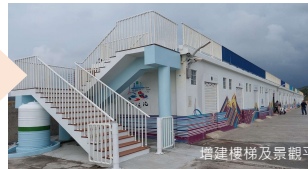
增建樓梯及景觀平台
