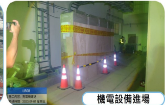
機電設備進場
