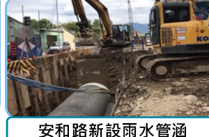
安和路新設雨水管涵
