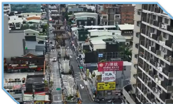
土城中央路狹窄路段LB001至LB02，尚餘井基1墩，大梁計有尾軌1跨，及路線段21跨待吊裝
