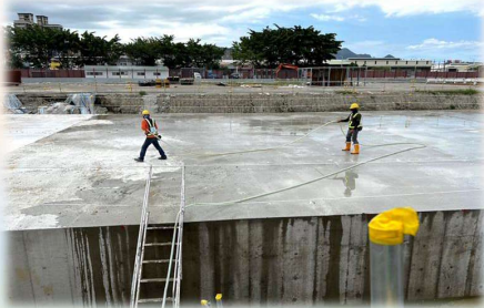
8之1號道路排水箱涵工程
