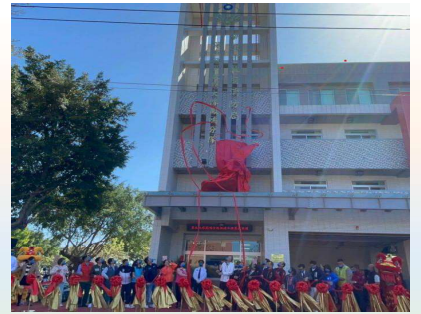
鳳鳴分隊興建工程
