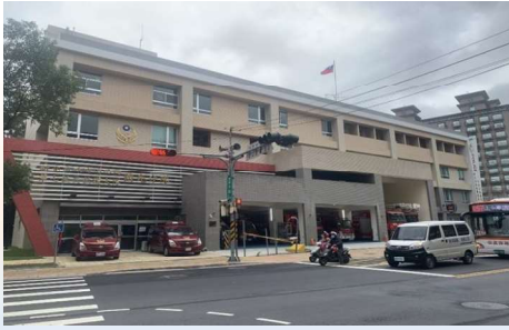
中和分局國光派出所與消防局國光分隊共構新建工程
