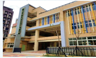
興穀國小整建暨公41工程
