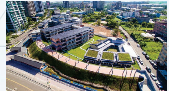
新林國小新建工程
