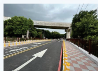
鶯歌區重慶橋
