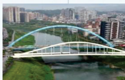
汐止江北橋 設計中， 預計115年12月完成
