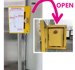
✓ 於 月台層候車區 增設緊急停車按鈕
