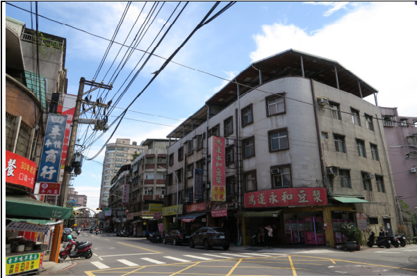
新莊區光明段重建前建物外觀
