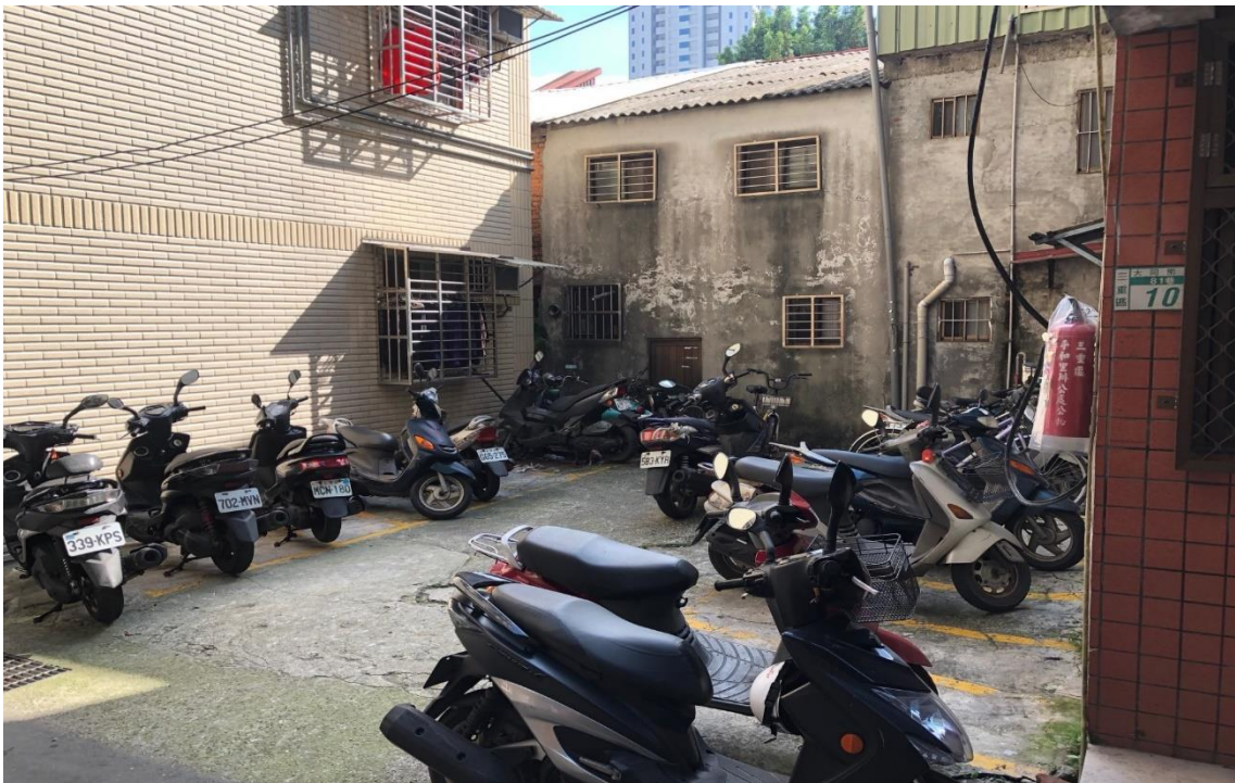
中民段 957 地號現況照
