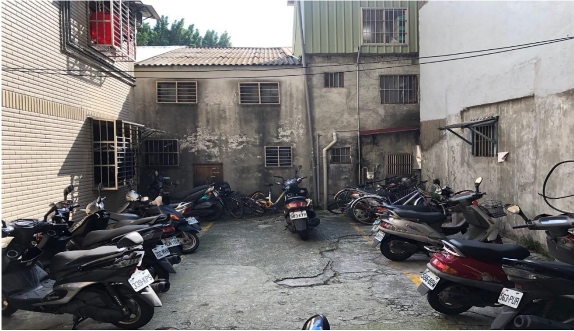
中民段 957 地號現況照
