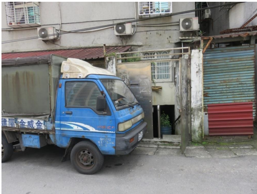
力行街 12 巷 3 號、12 巷 5 號、12 巷 1 弄 1 號地下室現況照
