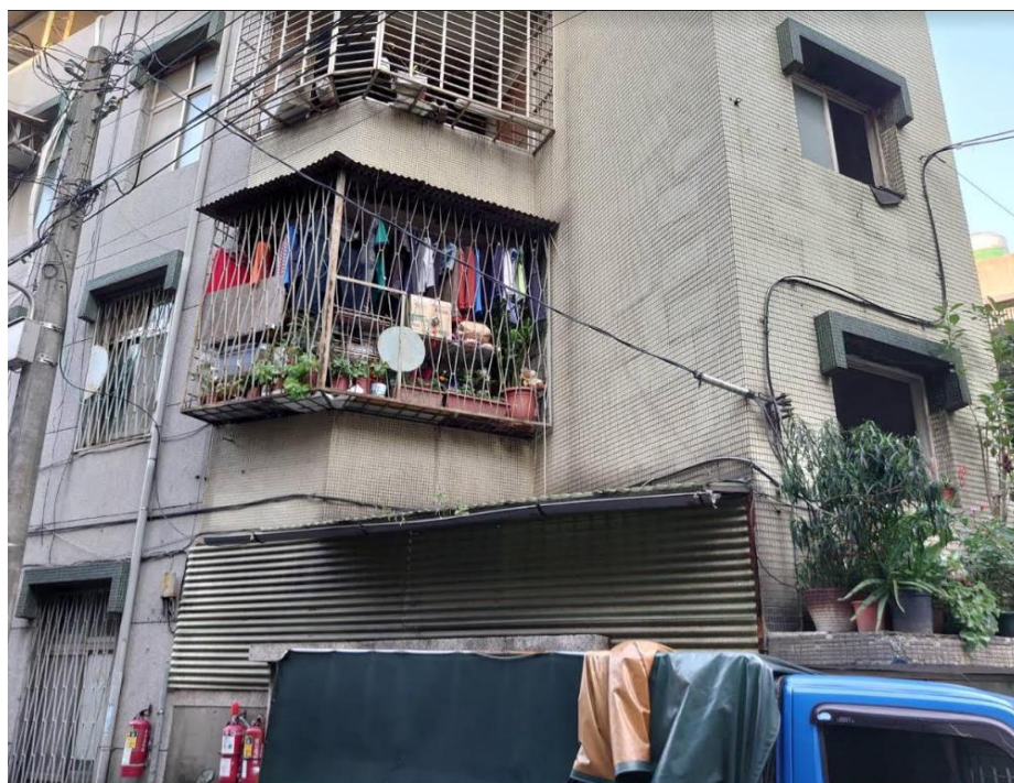
千歲街 70 巷 2 弄 7 號 2 樓現況照
