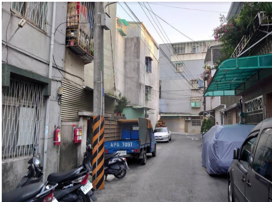
千歲街 70 巷 2 弄 7 號 2 樓現況照
