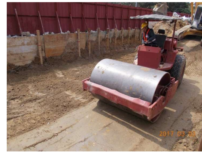
路基強化(土方回填夯實)
