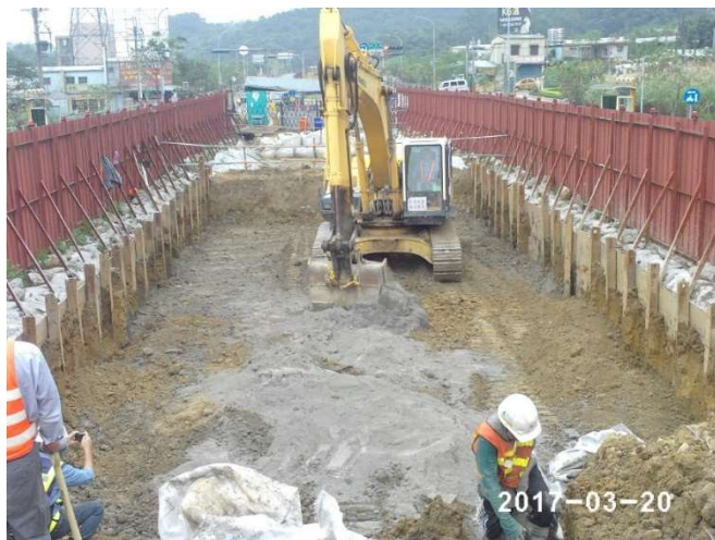
路基強化(撒佈水泥拌合)
