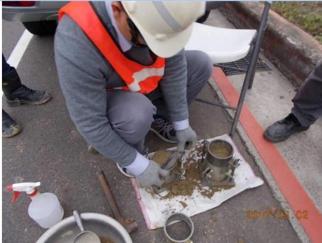
路基強化(試體取樣及製作)
